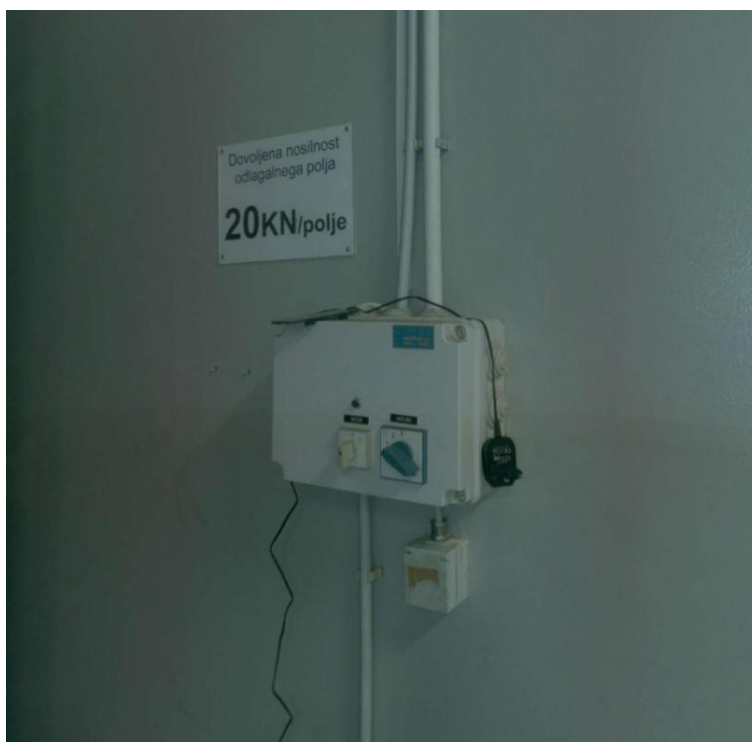
Slika 2., Obstoječa lokalna upravljalna omarica za električni grelec
