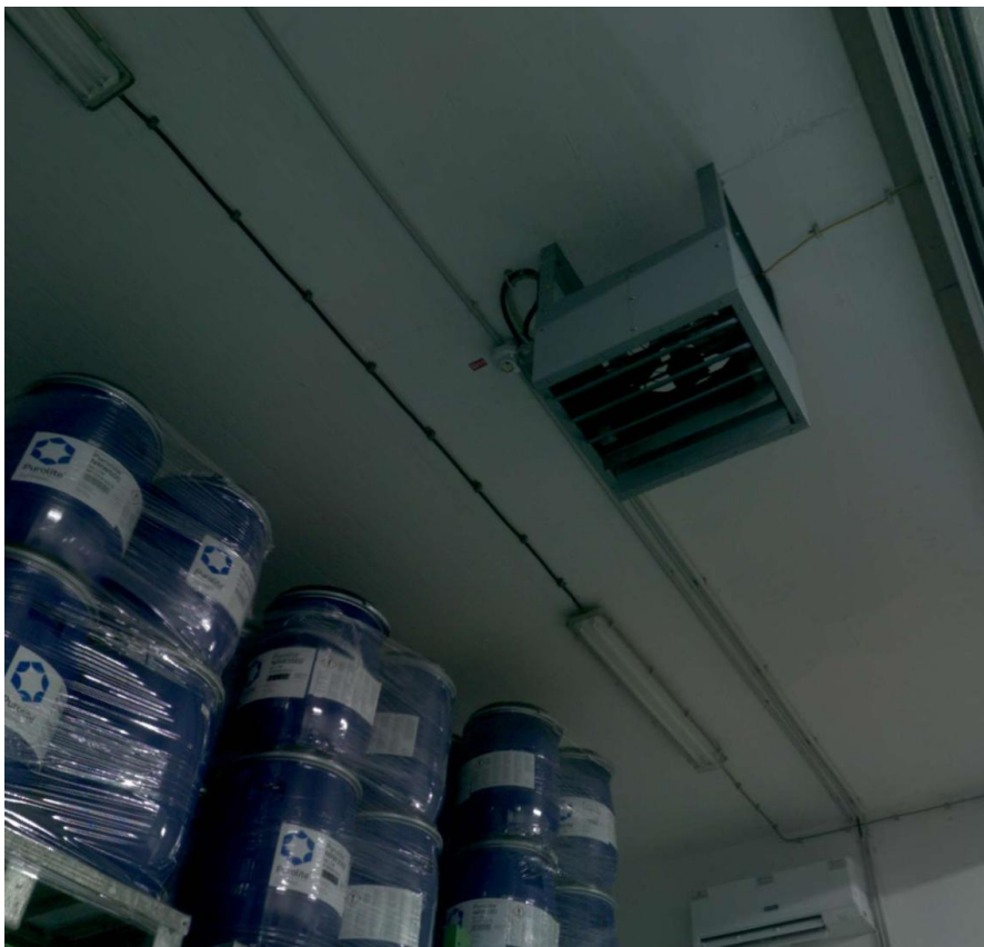
Slika 1., Električni grelec na stropu boksa
